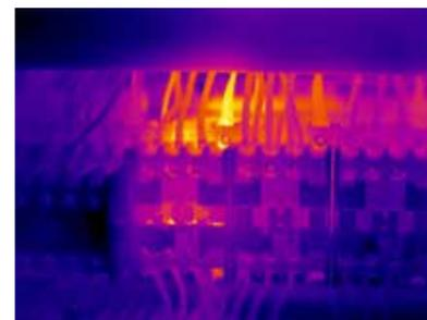
Vea el incremento de la resistencia en los bornes de conexión.
